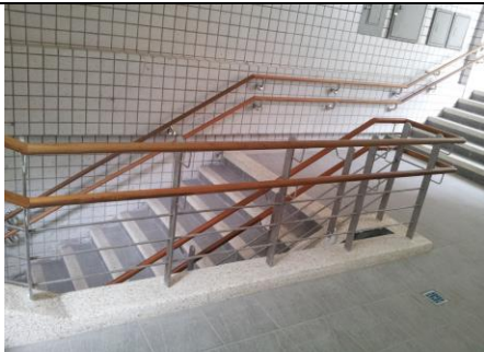
教學大樓樓梯整修完工
