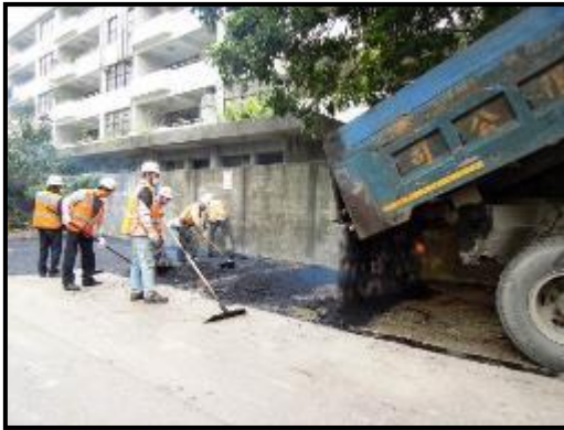
新工處重新鋪設路面。
