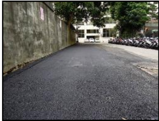
路面壓平後一路平坦。
