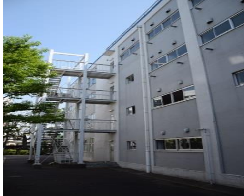
板橋有德高校建築物外避難梯。
