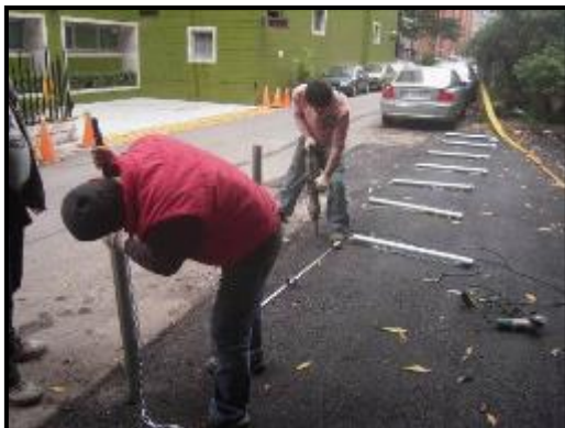
確認屬於校地設置安全圍籬。
